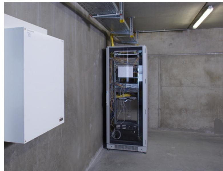
Bei einem Alarm wird der Wachdienst über eine Übertragungseinrichtung verständigt. Fällt hierbei der ISDN-Übertragungsweg aus, erkennt dies das System sofort und übermittelt den Alarm über den redundanten Übertragungsweg GSM.
